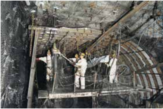
Blick auf die Arbeitsbühne
