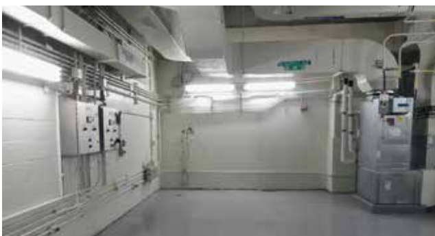
Betoninnenauskleidung nach den erfolgreichen Injektionsarbeiten
