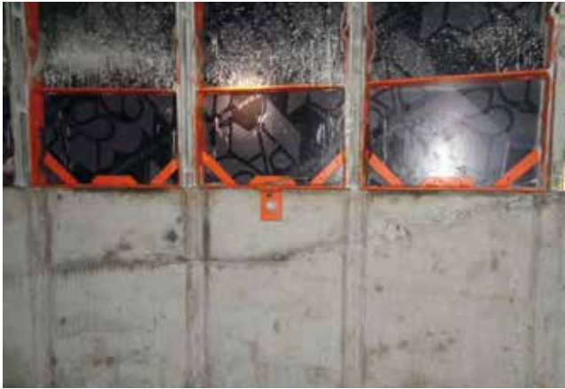
Erster Betonsatz der Ausbaustärkung Schacht 2 Borth nach dem Ausschalen
