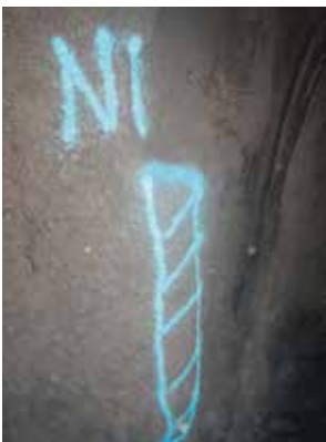
Bereich des Ausbruchs mit zusätzlich erforderlichem Materialabtrag
