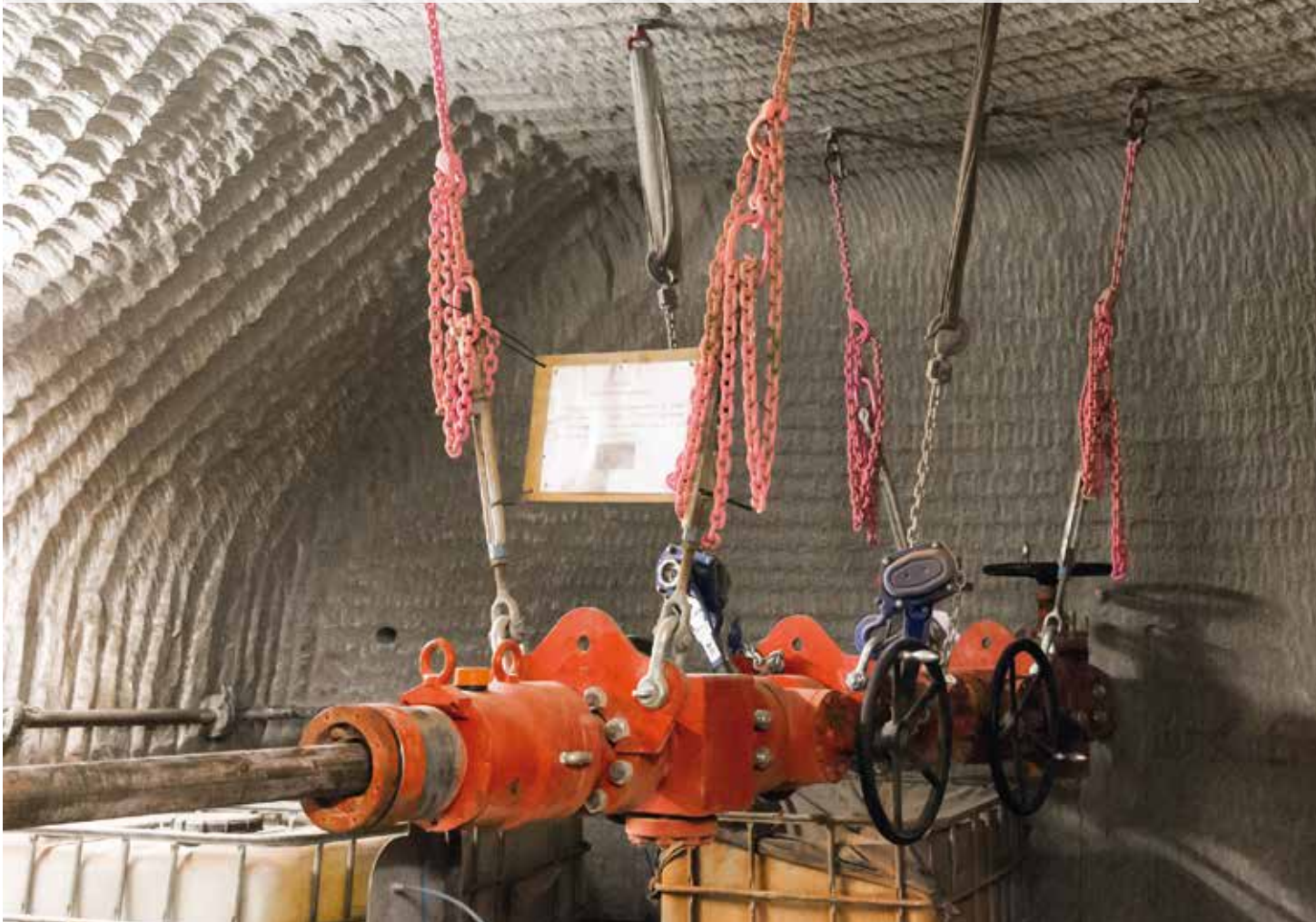
Preventerstack der untertägigen Erkundungsbohrung zur Füllortplanung Schacht Asse 5
