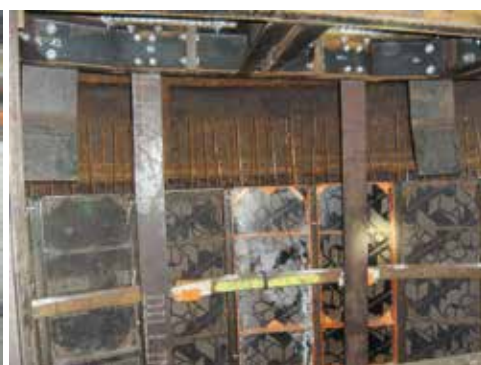
Oberkante der Systemschalung und überlappende Bewehrung
