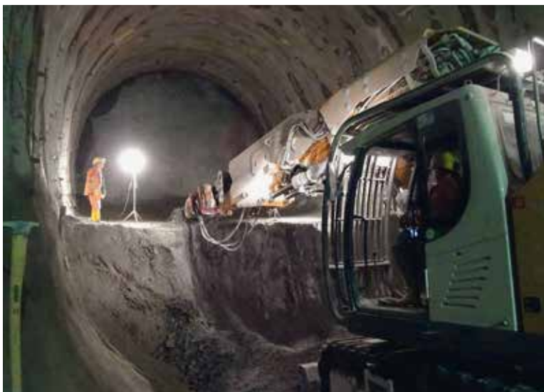
Strossen- und Sohlenvortrieb in der Hybridklasse
