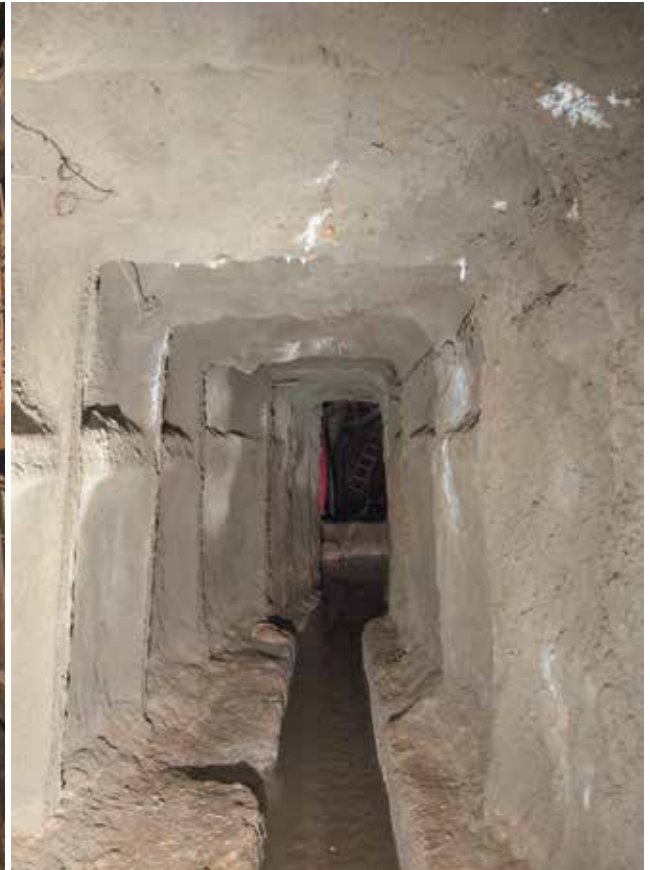
Mit Stahlausbau und Spritzbeton gesicherter Querschlag am Kunstschacht
