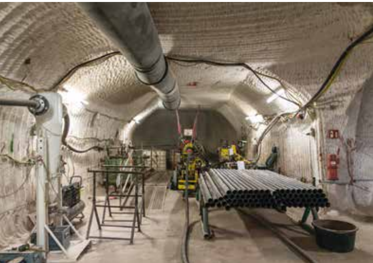
Bohranlage und Stangenlager auf der 574 m-Sohle
