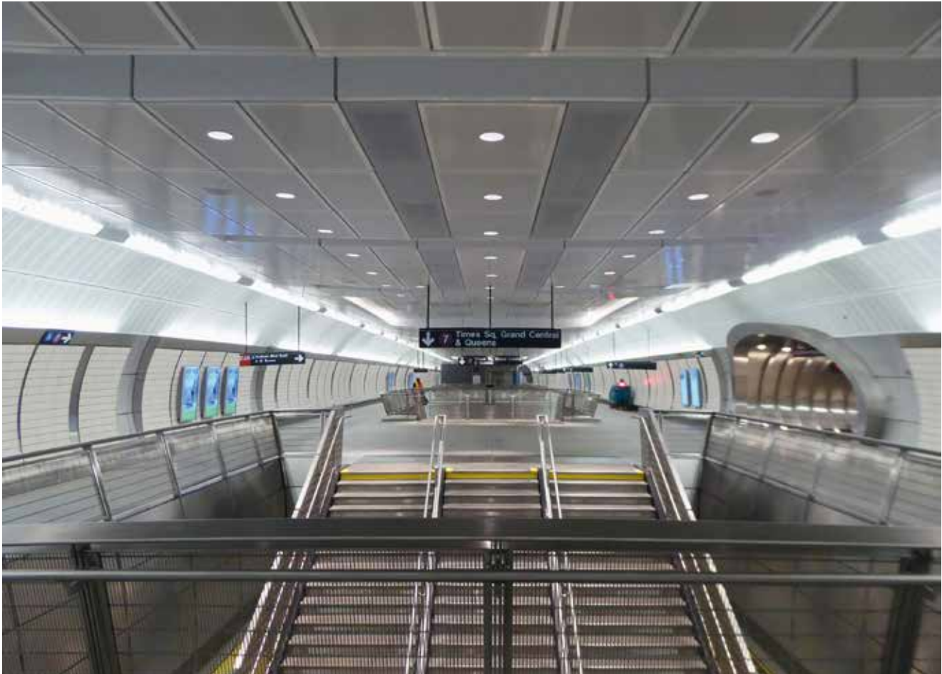
Innenauskleidung und Einbauten im Zugangsbereich der U-Bahnstation
