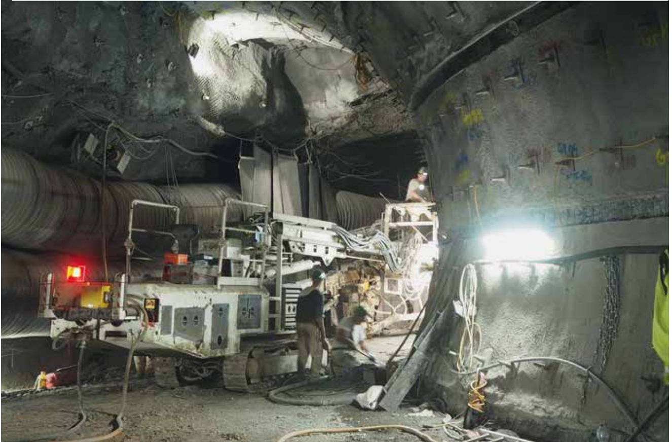
Streckenquerschnitt mit Ankerabau und Betonsicherung
