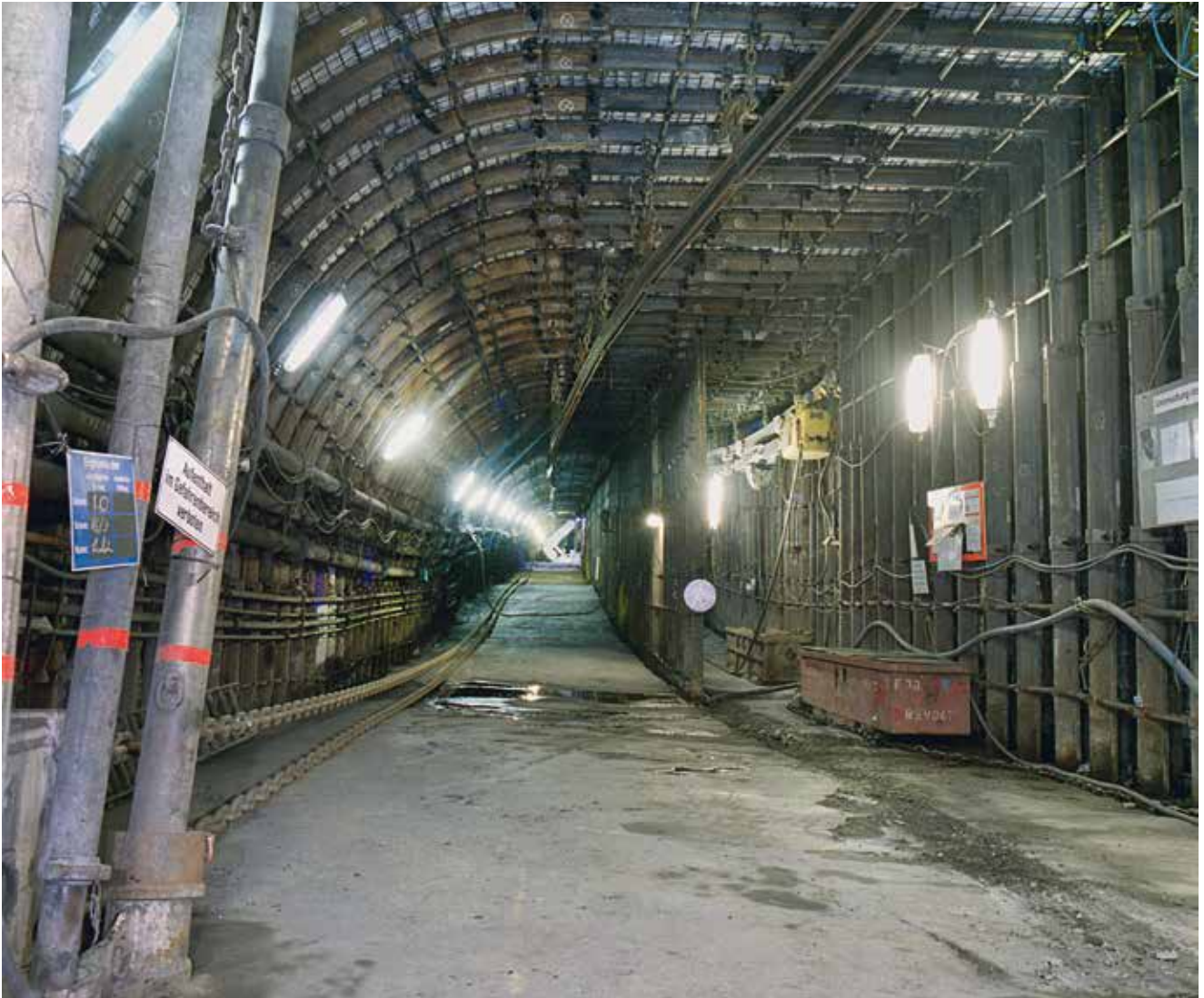
Fertige Einfahrtasse für den Schildausbau
