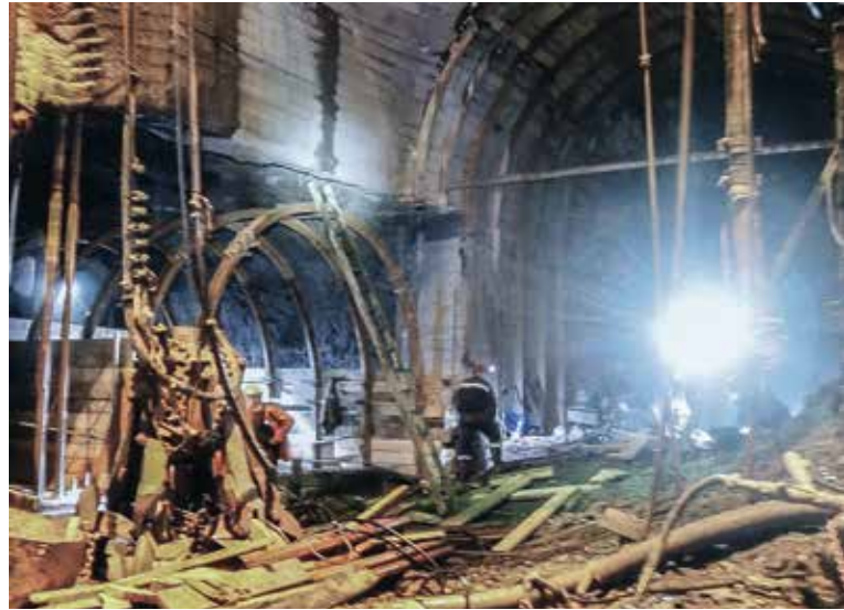
Montage der Betonschalung im Füllortbereich
