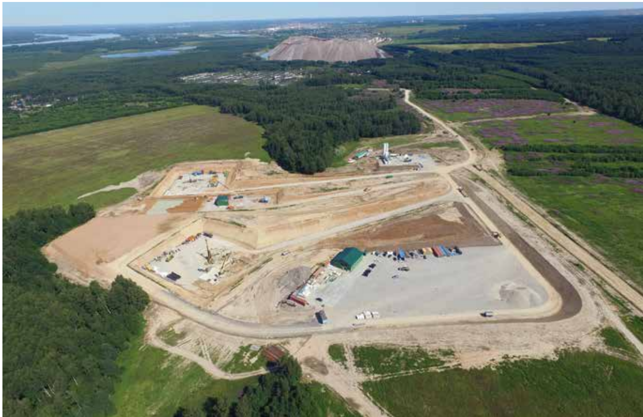
Die Baustelle SKRU-2. Stand der Arbeiten Juli 2016 (7 Monate nach Auftragsvergabe). Im Hintergrund sieht man die Salzhalde des Bergwerks SKRU-2, die Stadt Solikamsk sowie den Fluss Kama
