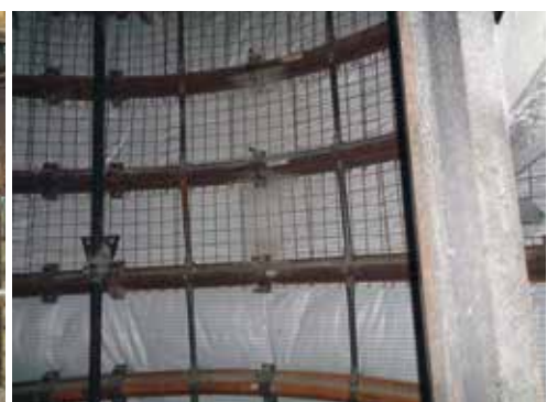
Stahlringausbau im Schacht Borth 1
