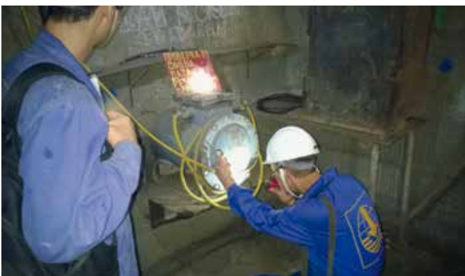
Baustellenaudit auf dem Bergwerk Donskoy GOK der TOO SCHACHTBAU Kasachstan
