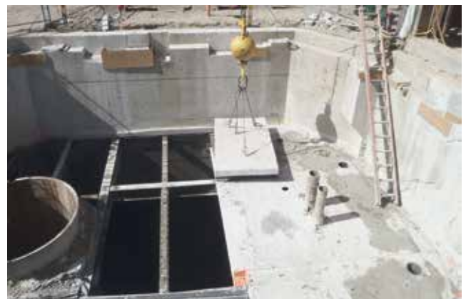
Beton- und Stahlrückbau am und unter dem vorhandenen Schachtkragen
