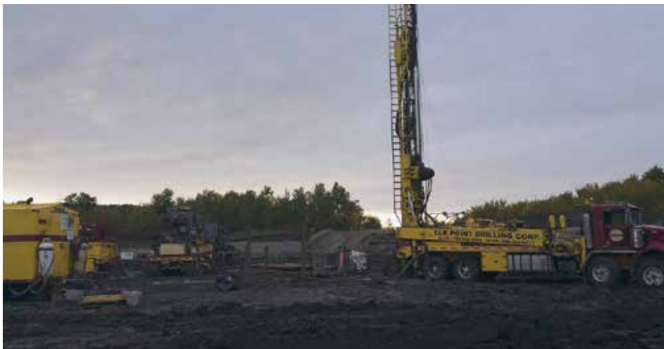
Die Bohranlage von Elk Point Drilling ist aufgestellt und einsatzbereit
