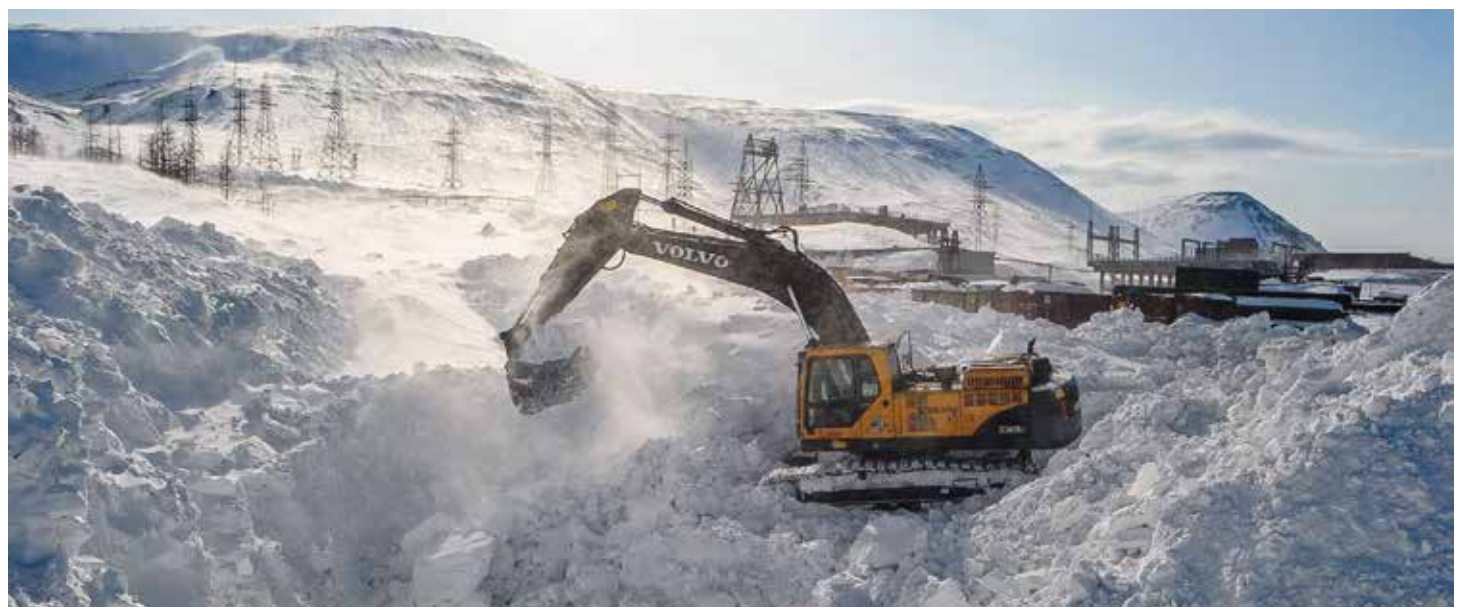
Übertägige Arbeiten unter schwierigen Bedingungen
