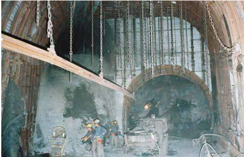
Erstellung eines Streckenabzweigs
