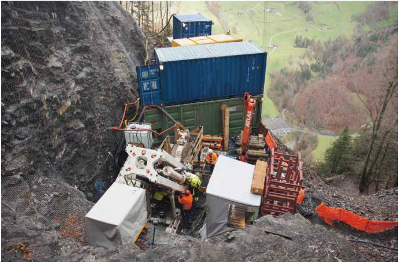
Bauplatz der Raisebohrereinrichtung
