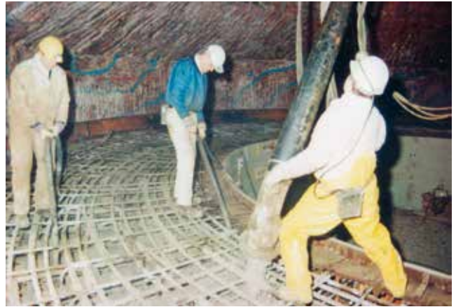
Herstellung des Aufstellfundaments zum Gleitschachtausbau
