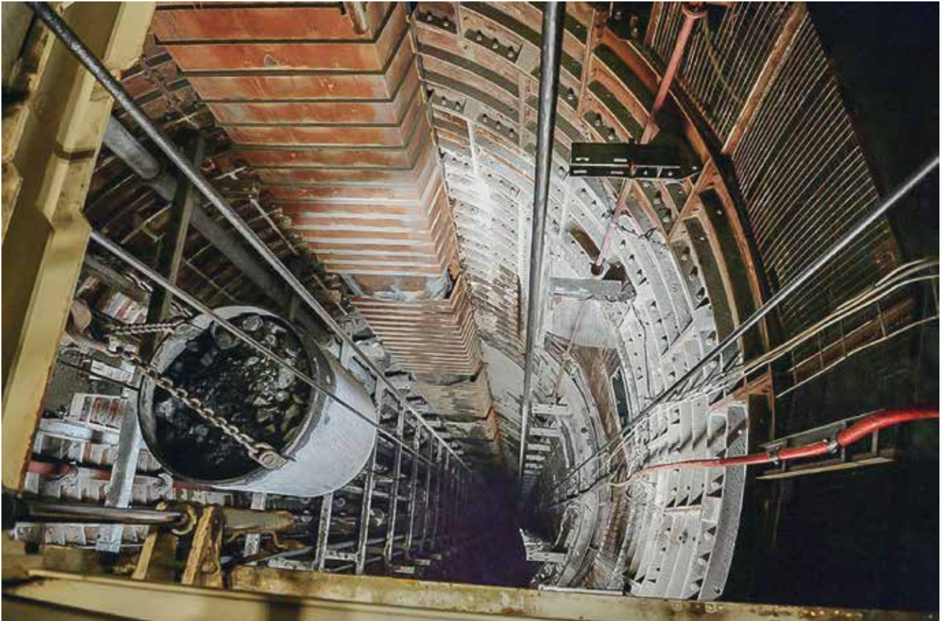
Blick in den Schacht mit Teufkübel
