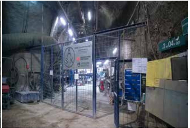
Baustellenaudit bei der Arbeitsgemeinschaft Schächte Konrad
