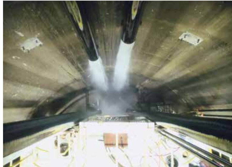
Blick von der Schwebebühne – Wasserhaltungssystem nahe der Schachtsohle
