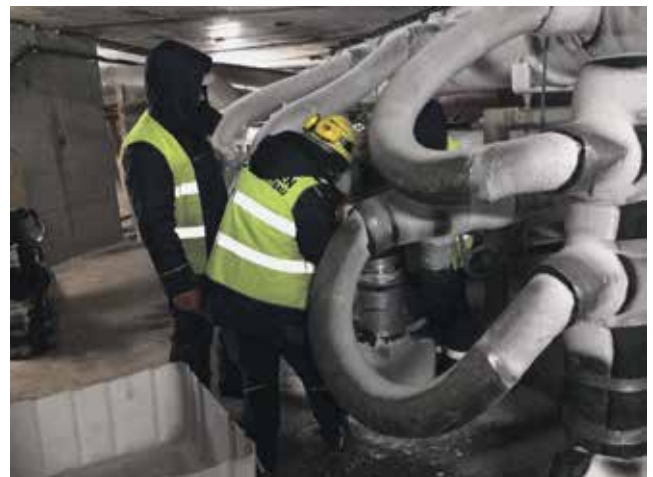
Die Kälte schlägt durch Eisbildung an den Gefrierrohrköpfen
