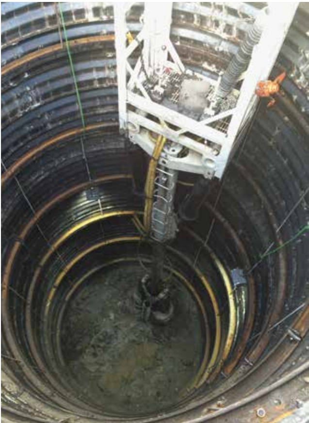
Vorschacht mit zu bergendem Bohrrohr
