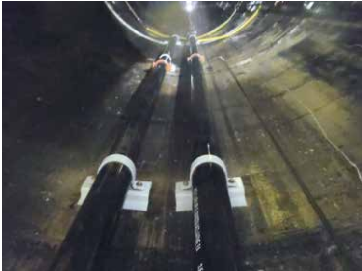
Blick von der Schwebebühne – Wasserhaltungssystem
