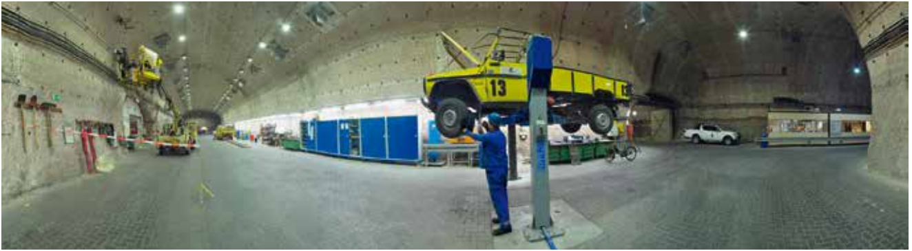
Werkstattbereich auf der 840 m-Sohle
