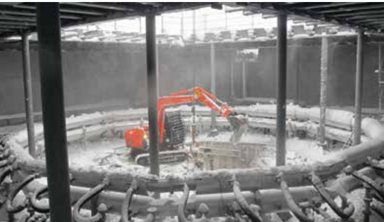
Der Baubeginn: Herstellen des Schachtkragens bis -13,5 m
