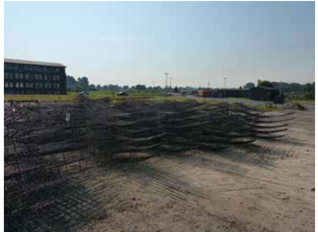
Bewehrungskörbe auf dem Schachtgelände zur Herstellung der Ausbauverstärkung
