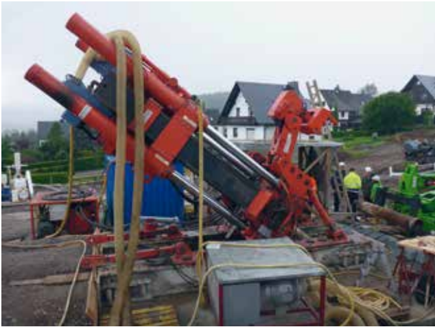
Schrägbohrung mit Raisebohrgerät Rhino 2007 DC zur Verbindung des Kaltwasserstolln mit dem Communstolln
