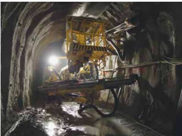
Drainagebohrungen mit Atlas Copco Bohrjumbo
