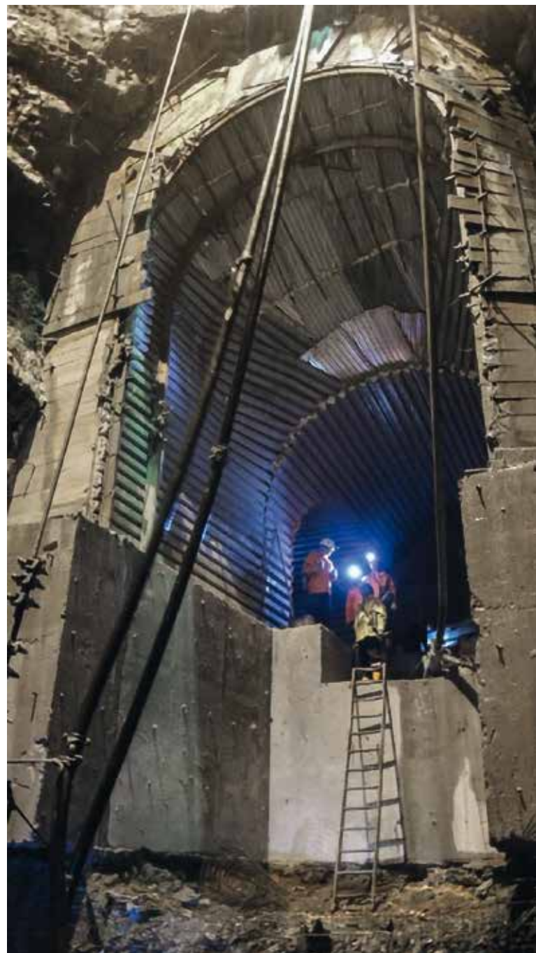
Betonausbau der Pumpenkammer
