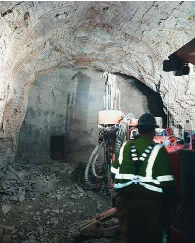
Einbringen der Gebirgssicherung
