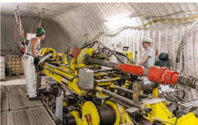
Nachsetzen von Gestänge im Bohrbetrieb auf der 574 m-Sohle
