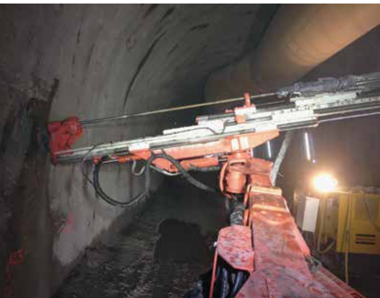
Detailansicht: Einbringen der Gebirgssicherung mit Ankerbohrwagen
