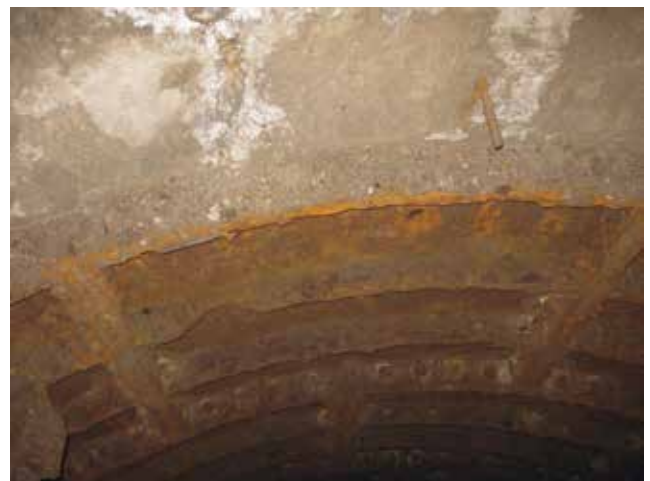
Gusseisen-Tübbingsegment nach der Abreinigung
