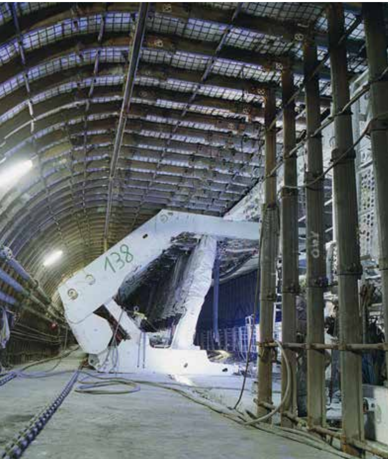
Fertig positioniertes Schild
