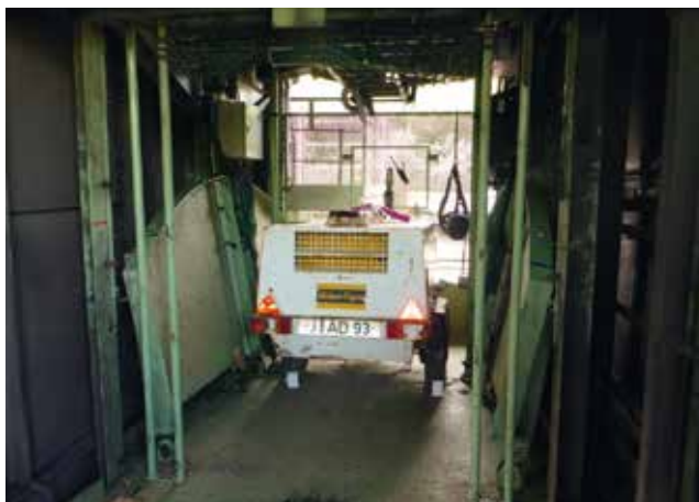
Schachtarbeitsbühne mit Kompressor am Anschlag der Rasenhängebank
