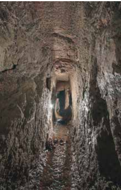
Außergewöhnlich schöne und standsichere Auffahrung des Kaltwasserstolln
