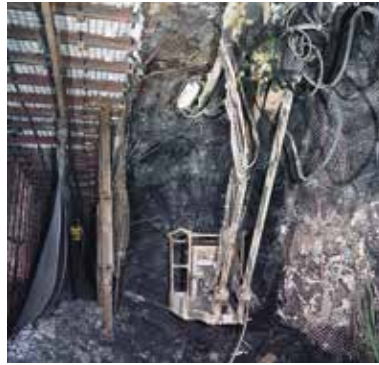
Auffahrung Begleitfeld mit Sprengschutz und Ankerbühne
