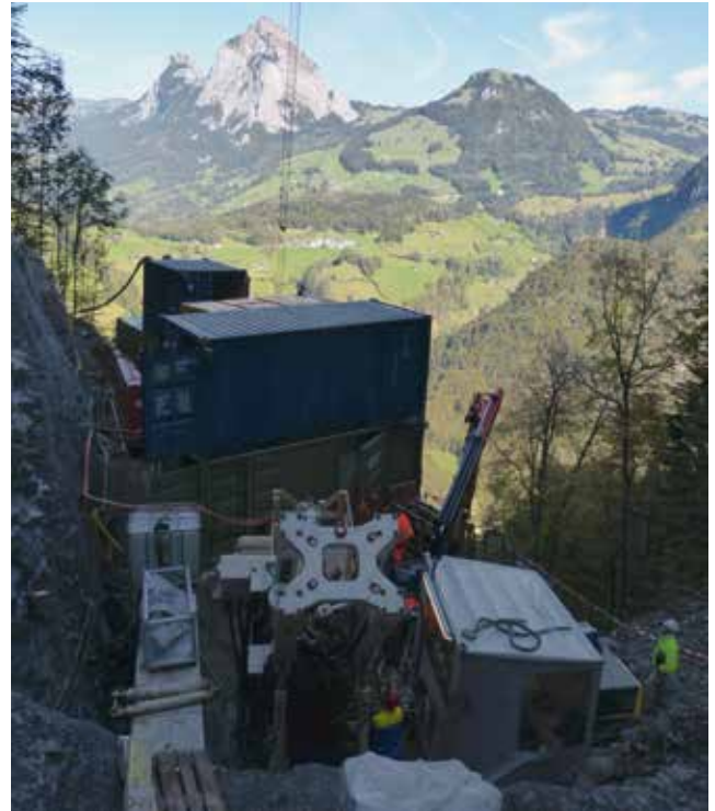
Eine große Herausforderung: Das Einrichten der Raisebohranlage in der Felswand auf etwa 900 m Höhe
