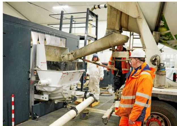
Der Betonmischer fährt rückwärts in die schallisolierte Halle und kippt 7,5 Kubikmeter Beton in den „Pumpenbug“. Von dort wird der Spezialbeton per Rohrleitung nach Schacht XII gepumpt.
