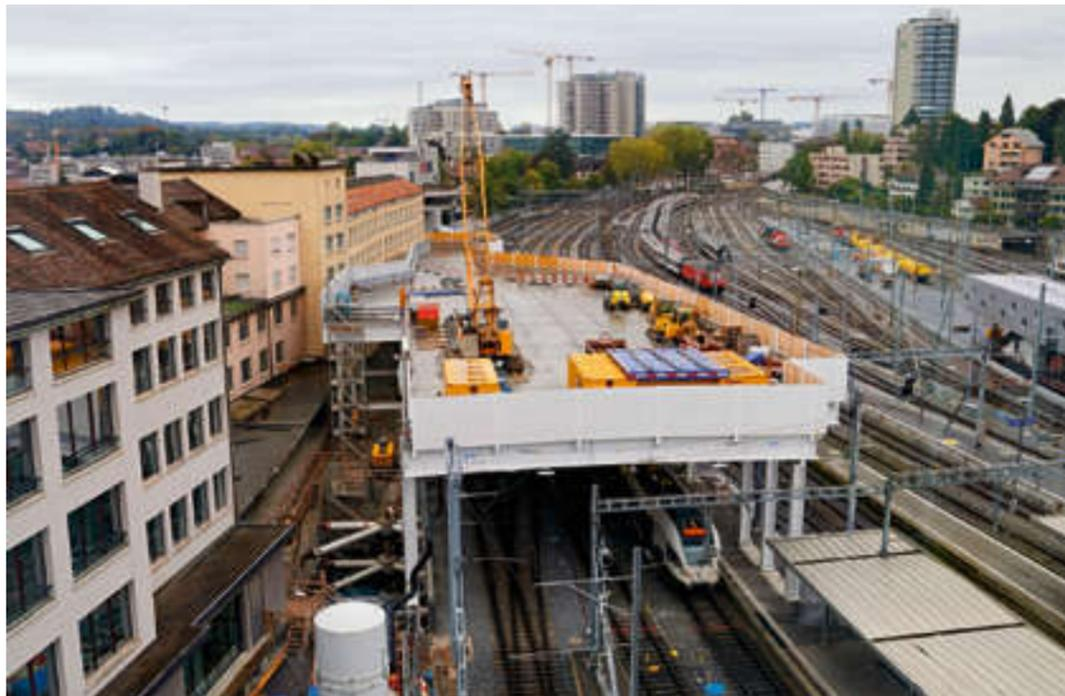
Die Stahlplattform über den Gleisen 1, 2 und 3 wurde errichtet, um den Materialnachschub zur unterirdischen Baustelle des neuen RBS-Bahnhofs zu sichern.
