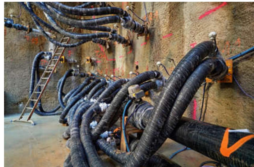
Was für Normalbürger wie ein Schlauchsalat aussieht, ist Teil des Gefriersystems, das die Stabilisierung des Bodens gewährleistet.
