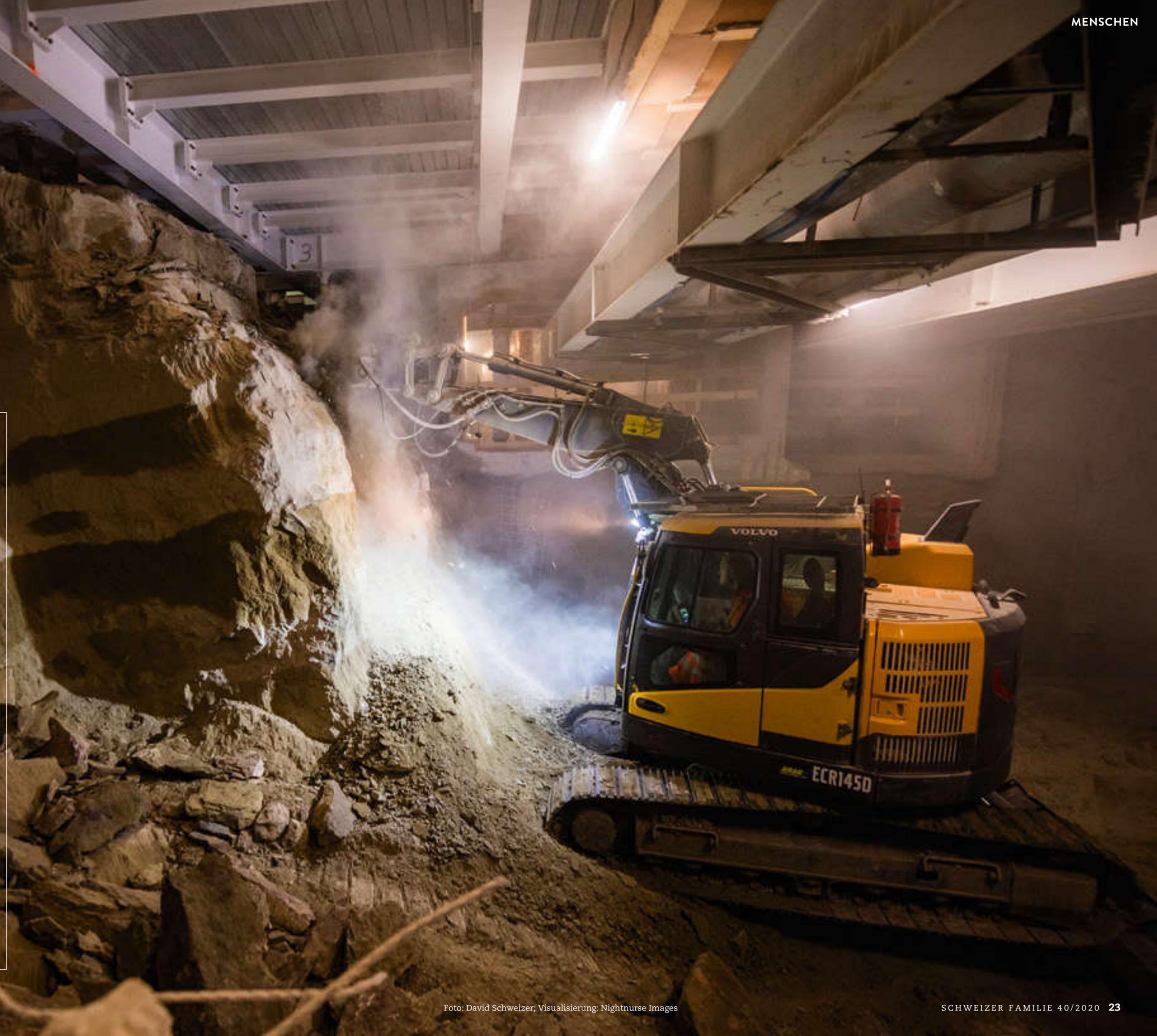
Olaf Walter baut die Stützen, um die Lasten abzufangen, die auf den Perrons und den Gleisen liegen.
