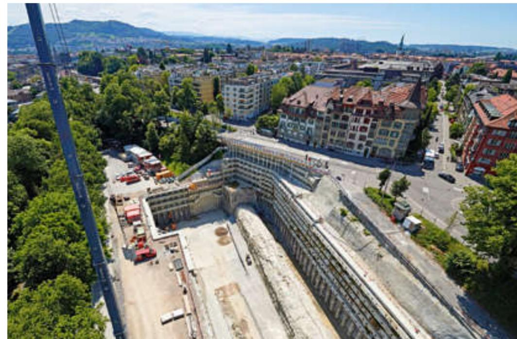
Nördlich vom Bahnhof klafft ein 160 Meter langer und 30 Meter breiter Krater. Von hier aus errichtet der Regionalverkehr RBS den Zugangstunnel zum neuen Tiefbahnhof.
