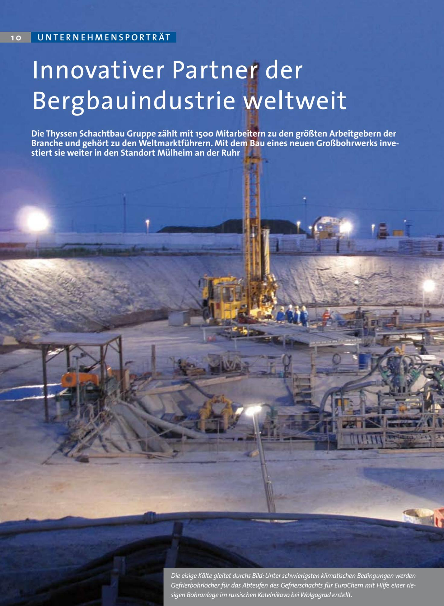
Die eisige Kälte gleitet durchs Bild: Unter schwierigsten klimatischen Bedingungen werden Gefrierbohrlöcher für das Abteufen des Gefrierschachts für EuroChem mit Hilfe einer riesigen Bohranlage im russischen Kotelnikovo bei Wolgograd erstellt.
